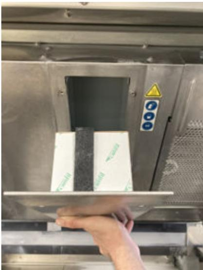
7. Установите каркас фильтра на место и затяните шесть крепящих его винтов.
