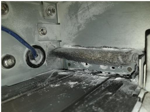
6. Очистите скребки вакуумным очистителем, одновременно удаляя грязь пальцами. Результат должен выглядеть следующим образом:
